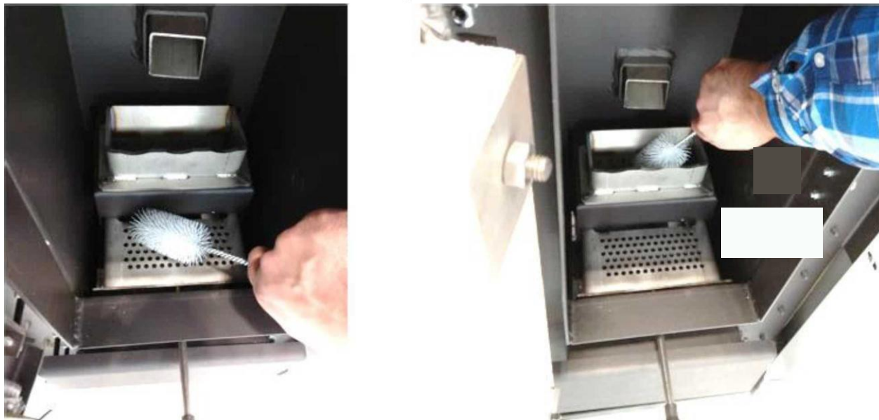
CURĂȚAREA CAMEREI BOILERULUI (peria nu este inclusă cu boilerul)
