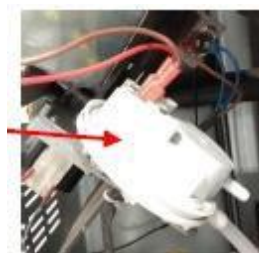
Comutator de presiune al coșului în boiler
